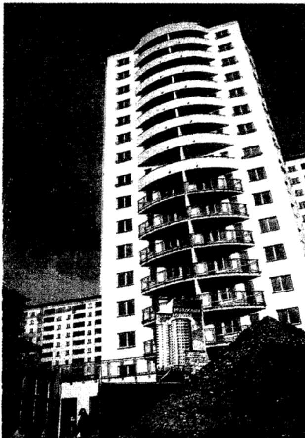
W ofercie J.W. Construction Holding dominują mieszkania popularne, czyli adresowane do średniozamożnych klientów. Na zdjęciu: kompleks Mokotów Plaza w Warszawie.
